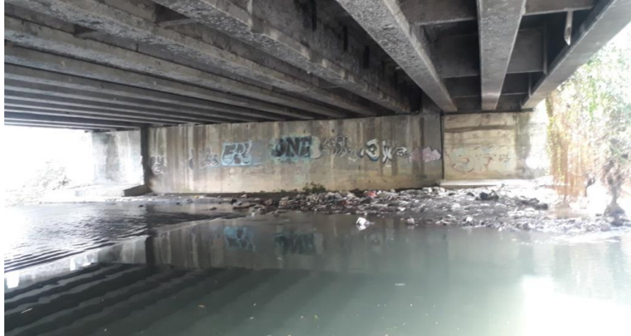
Gambar 4.14 Keadaan sekitar sungai di Jembatan Ringroad Selatan (Kabupaten Bantul)
