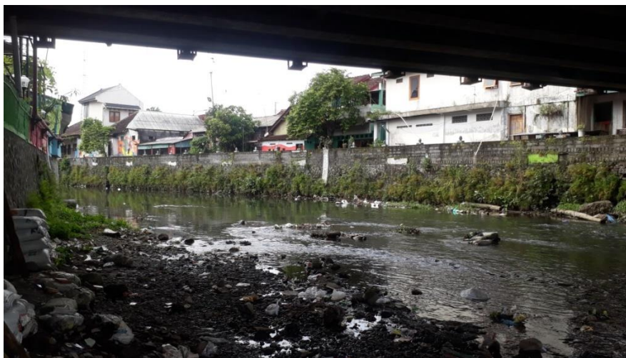
Gambar 4.13 Keadaan sekitar sungai di Jembatan Sayidan (Kota Yogyakarta)
