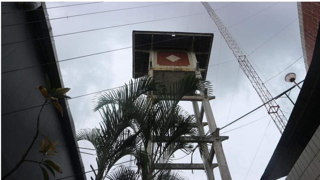
Gambar 4.3 Bak Penampung Berkapasitas  $64 \text{ m}^3$  .
