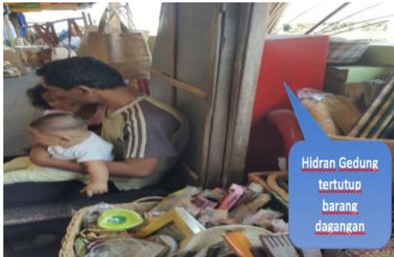
Gambar 4.17 Kondisi Hidran Gedung Tertutup Barang Dagangan
