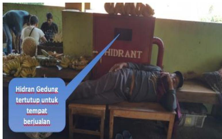
Gambar 4.18 Kondisi Hidran Gedung Untuk Tempat Dagangan
