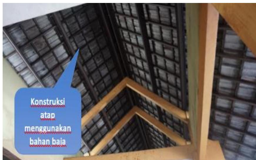
Gambar 4.21 Konstruksi Atap Menggunakan Baja
