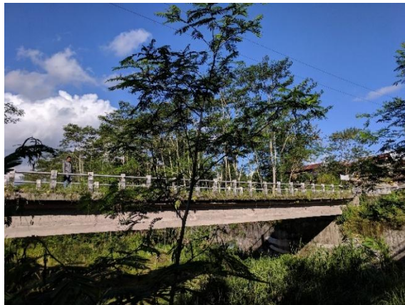
Gambar 4.12 Contoh jembatan beton
