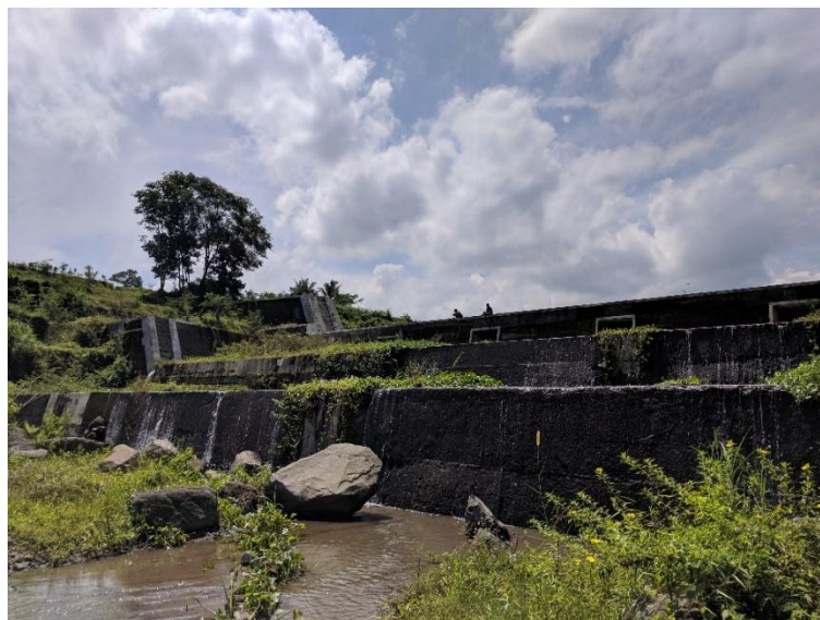
Gambar 4.54 Sabo dam dengan kategori check dam
