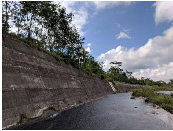
Gambar 4.24 Contoh dinding penahan tanah dari beton
