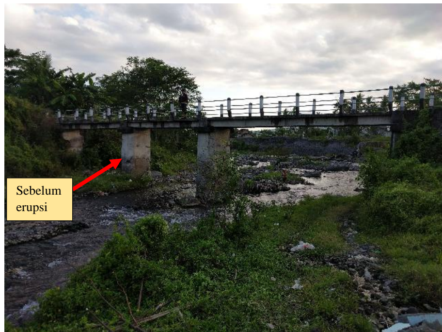
Gambar 4.42 Jembatan beton di daerah Desa Sirahan
