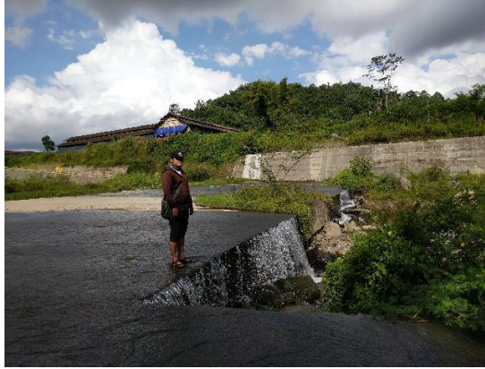
Gambar 4.16 Contoh bangunan groundsill
