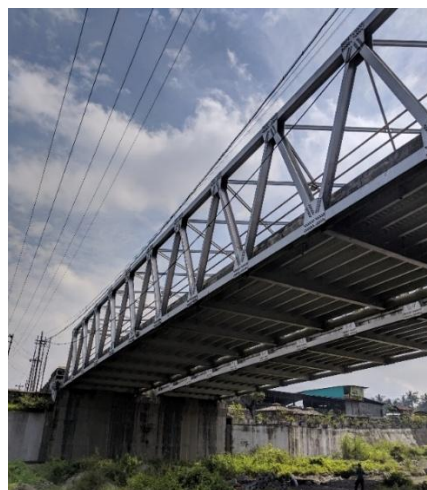
Gambar 4.38 Jembatan rangka baja Jalan Magelang
