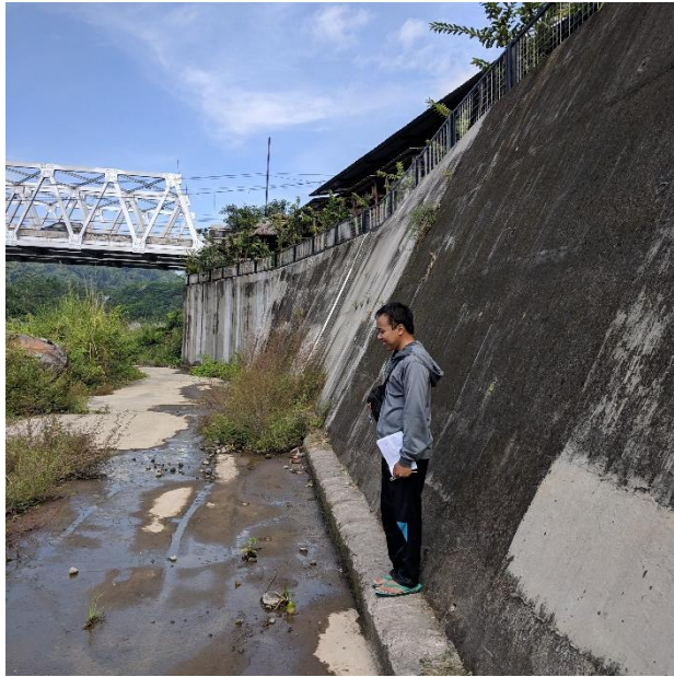
Gambar 4.39 Dinding penahan tanah pada jembatan di Jalan Magelang
