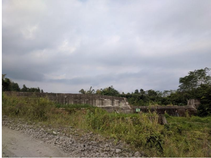
Gambar 4.51 Sabo dam dengan kategori consolidation dam
