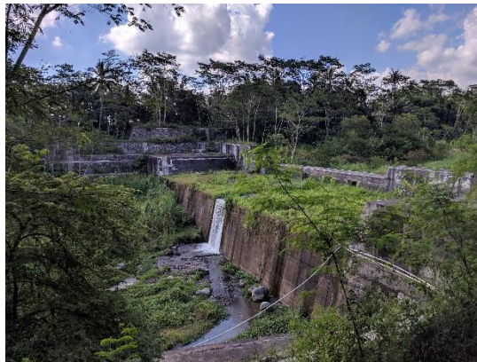
Gambar 4.15 Contoh bangunan sabo dam
