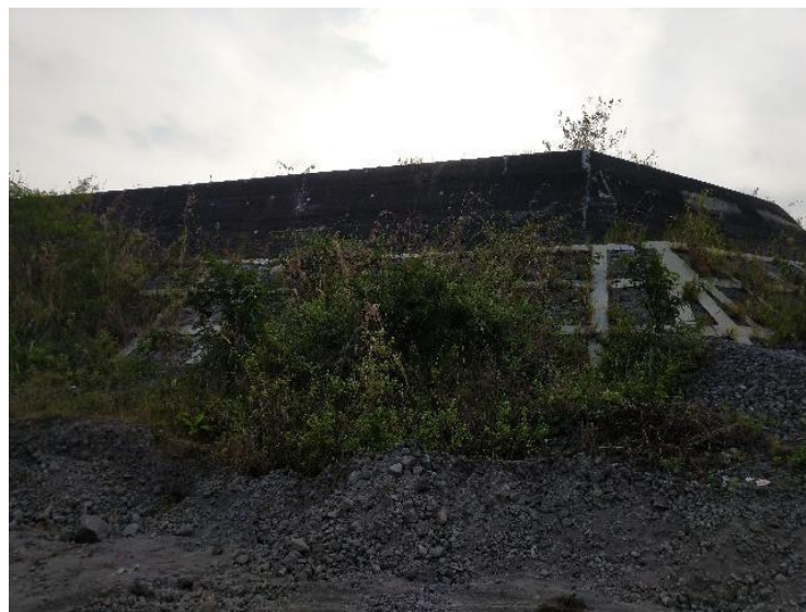
Gambar 4.59 Dinding penahan tanah di lokasi bangunan kantung pasir
