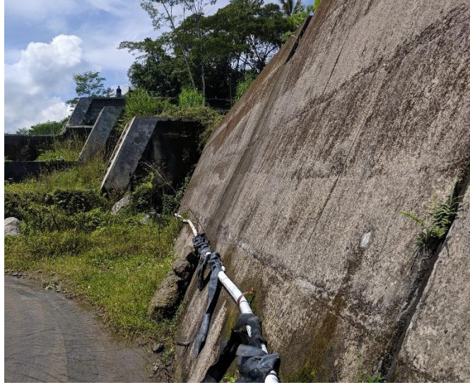
Gambar 4.55 Dinding penahan tanah pada lokasi check dam
