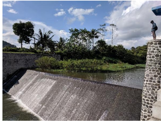
Gambar 4.14 Contoh bangunan bendung
