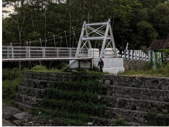
Gambar 4.23 Contoh dinding penahan tanah berupa bronjong
