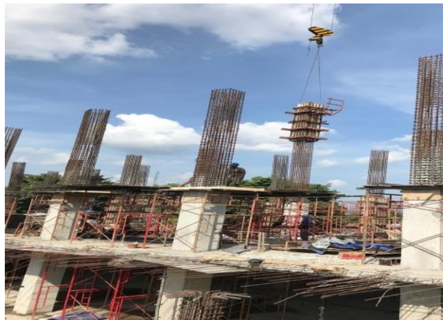
Gambar 4.9. Pemasangan Bekisting Untuk Kolom Dan Dinding Pada Area Proyek
