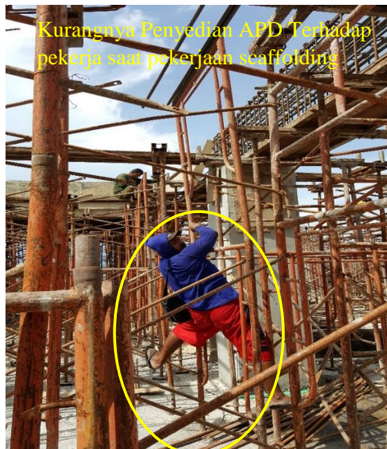
Gambar 4.14. Pekerjaan Pembekistingan Scaffolding Lantai Tujuh Proyek Pembangunan Gedung C Universitas Aisyiyah Yogyakarta
