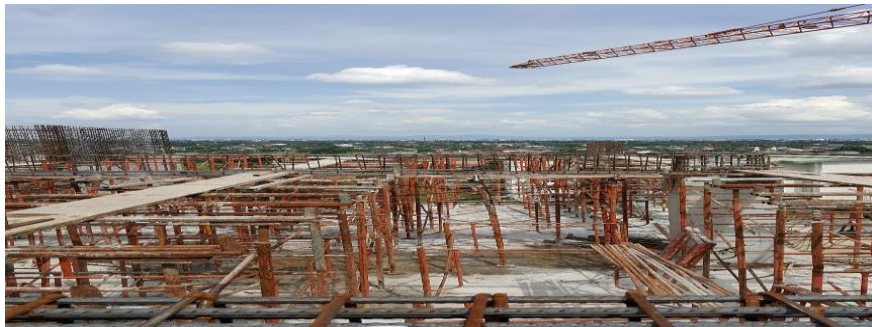
Gambar 4.13. Pekerjaan Pembekistingan Scaffolding Pada Lantai Tujuh Proyek Pembangunan Gedung C Universitas Aisyiyah Yogyakarta
