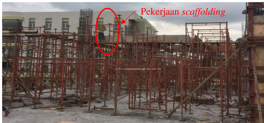
Gambar 4.7. Pemasangan Scaffolding
