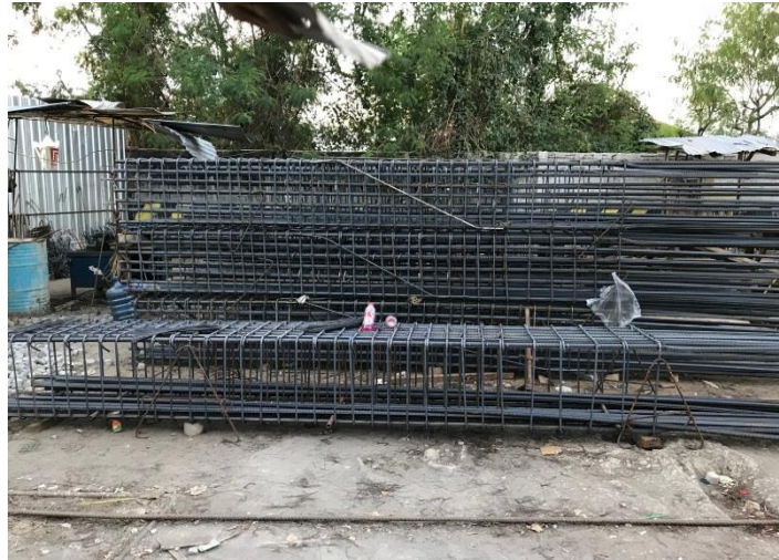
Gambar 4.21. Pekerjaan Pembesian Perakitan Tulangan Kolom Pada Area Proyek
