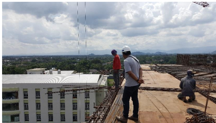
Gambar 4.31. kondisi lapangan pekerjaan siang hari di proyek pembangunan Gedung C Universitas Aisyiyah Yogyakarta
