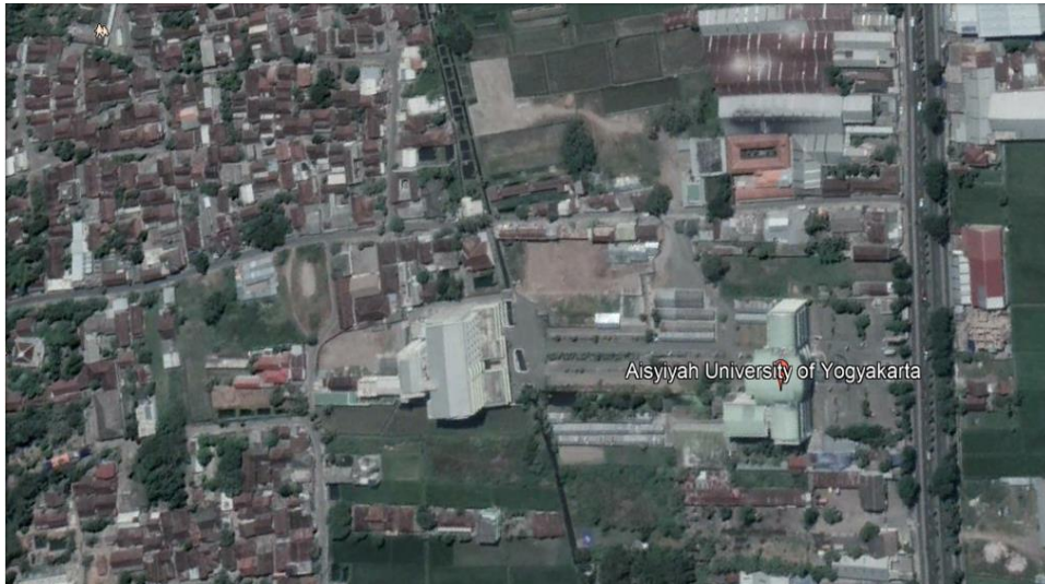
Gambar 4.1. Foto Udara Proyek Pembangunan Gedung C Universitas Aisyiyah Yogyakarta
