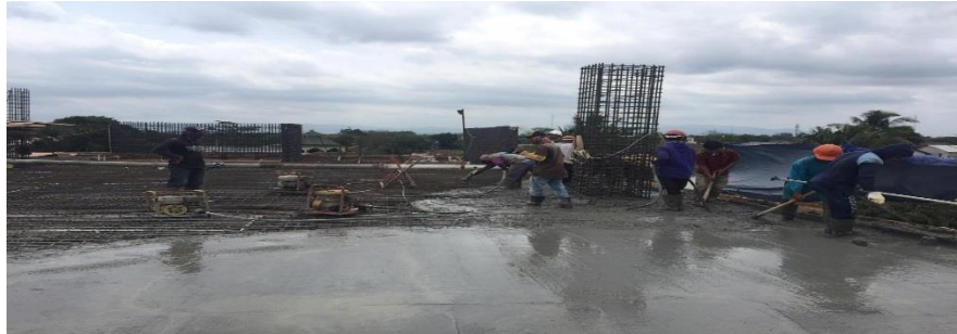
Gambar 4.29. Pemerataan Beton Segar Pekerjaan Pengecoran Proyek
