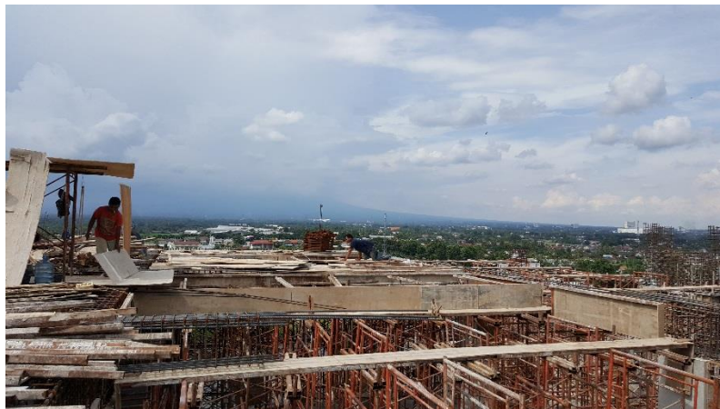
Gambar 4.12. Pekerjaan Pembekistingan Lantai dan Balok Pada Lantai Tujuh Proyek Pembangunan Gedung C Universitas Aisyiyah Yogyakarta
