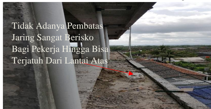
Gambar 4.6. Tidak Adanya Pembatas Jaring Pengaman Di Proyek
