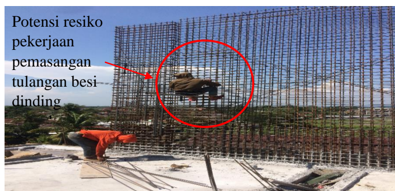
Gambar 4.23. Pekerjaan Pemasangan Tulangan Dinding Proyek
