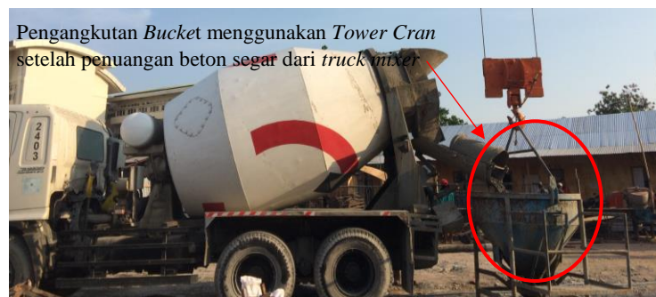
Gambar 4.27. Proses Pengangkutan Beton Segar Menggunakan Bucket Proyek
