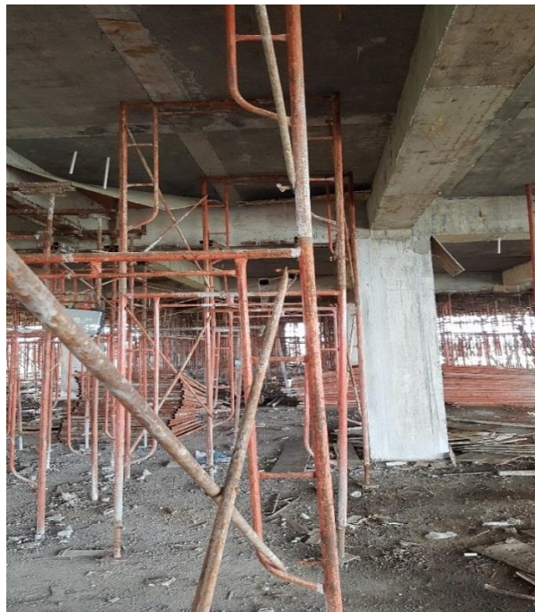
Gambar 4.16. Kondisi Lapangan Pekerjaan Pembongkaran Bekisting
