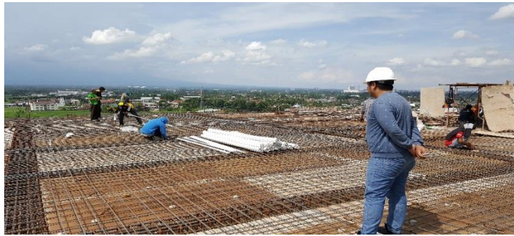
Gambar 4.30. kondisi lapangan pekerjaan siang hari di proyek pembangunan Gedung C Universitas Aisyiyah Yogyakarta
