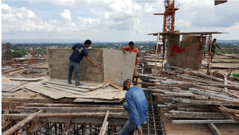
Gambar 4.8. Pekerjaan Perakitan Body Bekisting Kolom dan Dinding
