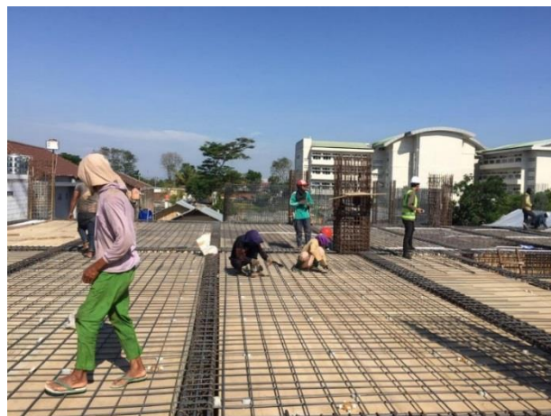
Gambar 4.18. Pekerjaan Pemotongan Besi (plat lantai) Proyek Pembangunan Gedung C Universitas Aisyiyah Yogyakarta
