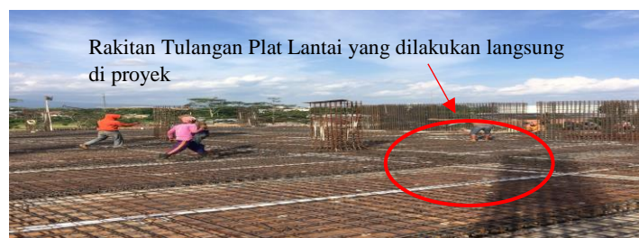
Gambar 4.24. Pekerjaan Pembesian Perakitan Tulangan Lantai (plat lantai) Proyek
