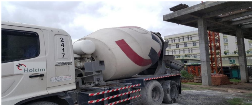
Gambar 4.26. Penempatan Truck Mixer Untuk Pengecoran Proyek
