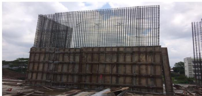
Gambar 4.11. Hasil Penempatan Body Bekisting Untuk Dinding Menggunakan Tower Crane
