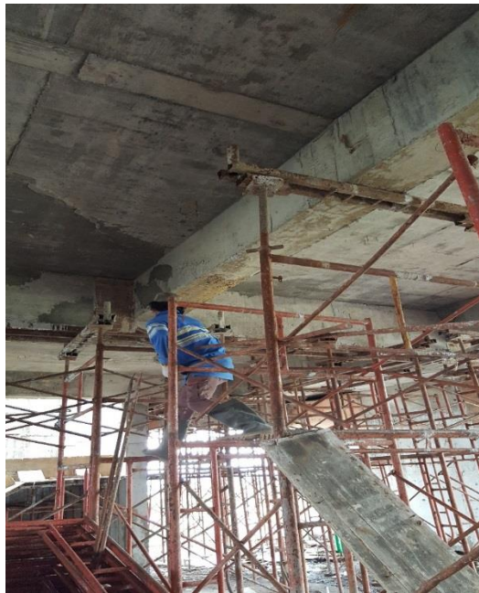
Gambar 4.15. Pembongkaran Bekisting Penopang Lantai Gedung
