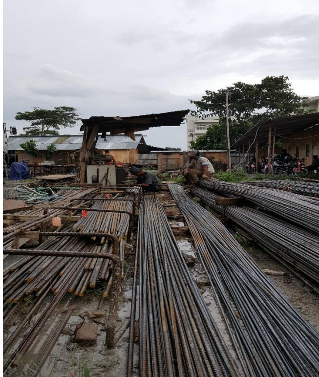
Gambar 4.19. Pekerjaan Pemotongan Besi Tulangan Balok Kolom Dinding Proyek
