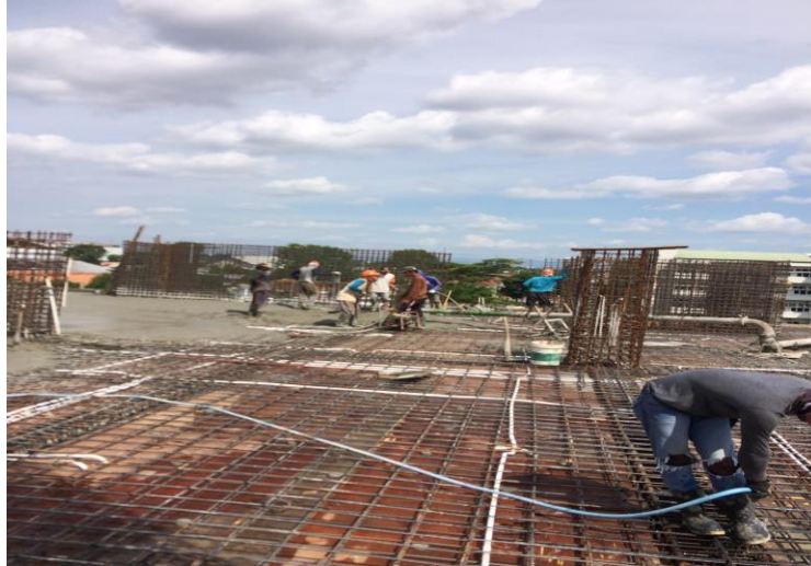
Gambar 4.25. Pekerjaan Pembersihan Area Pengecoran Pada Proyek
