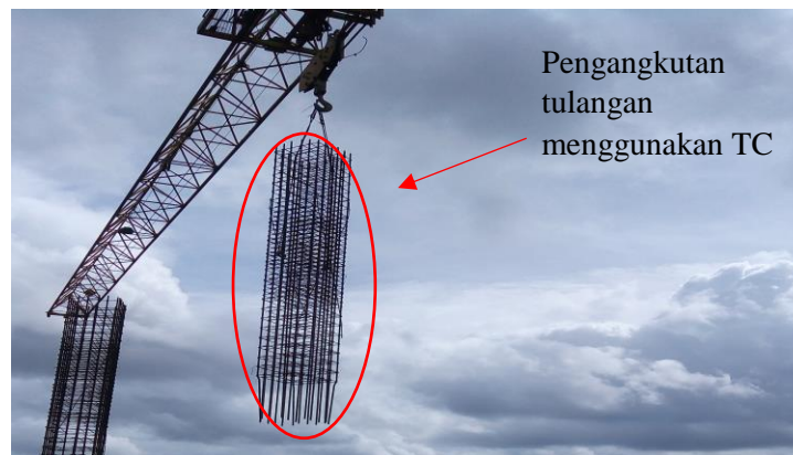
Gambar 4.20. Pekerjaan Pemesanan Perakitan Tulangan Balok, Kolom dan Dinding Pada Area Proyek
