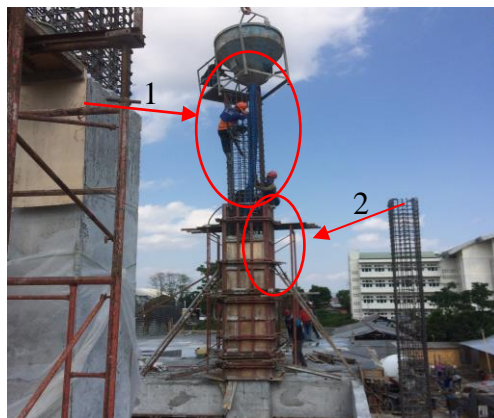
Gambar 4.28. Proses Pengecoran Kolom Dan Pemadatan Kolom Menggunakan Vibrator Concrete Pada Proyek
