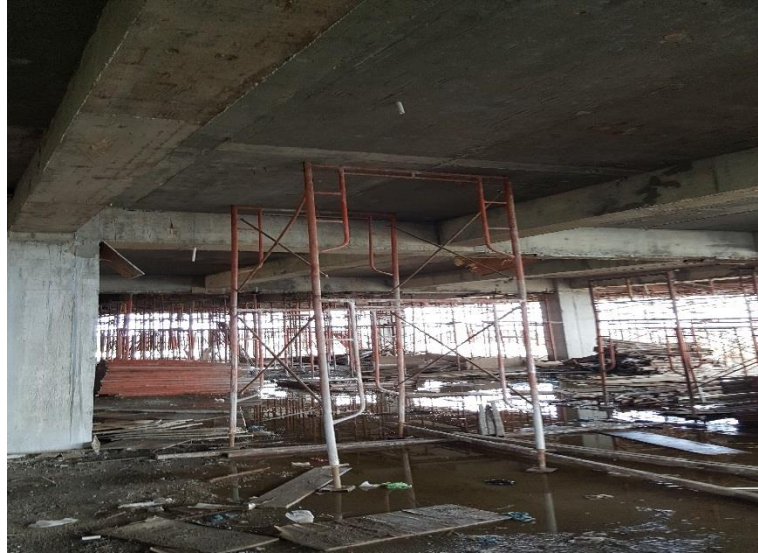
Gambar 4.17. Tidak Adanya Pekerja Pembersihan Pada Area Bekisting Proyek
