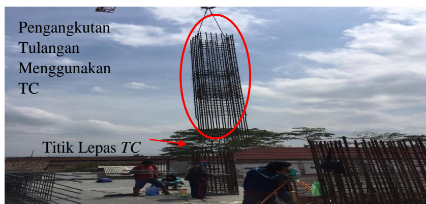
Gambar 4.22. Pengangkutan Tulangan Kolom Menggunakan TC Proyek
