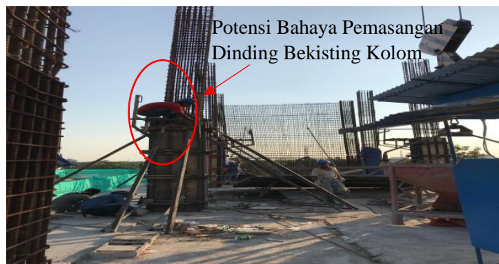
Gambar 4.10. Pemasangan Dinding Bekisting Kolom
