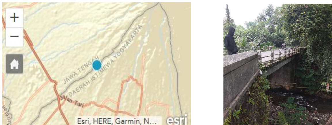
Gambar 4.23 Lokasi jembatan J6
