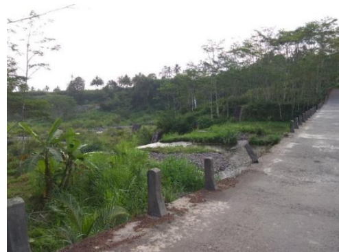
Gambar 12 Kondisi Sempadan bagian hulu Sungai Krasak
