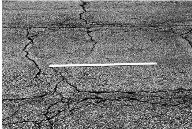
Gambar 2. 11 Retak kotak-kotak (ASTM, 2007)
