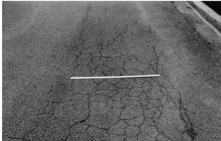
Gambar 2. 7 Kerusakan retak kulit buaya (ASTM, 2007)
