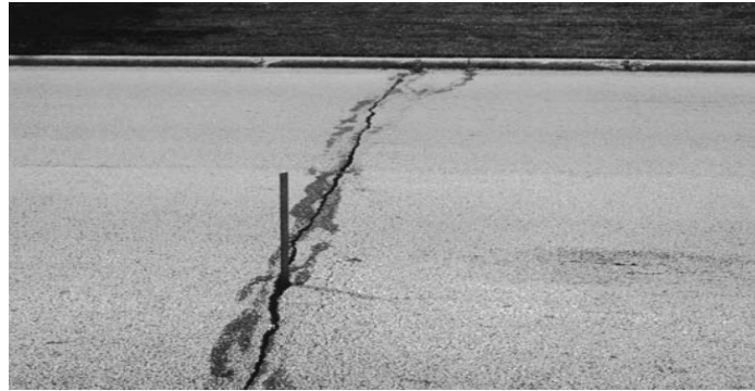
Gambar 2. 25 Retak melintang atau memanjang (ASTM, 2007)
