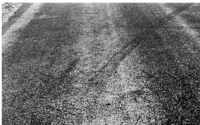
Gambar 2. 9Kerusakan kegemukan ( Bleeding ) (ASTM, 2007)
