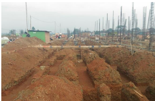
Gambar 4.1 Hasil pekerjaan bouwplank
