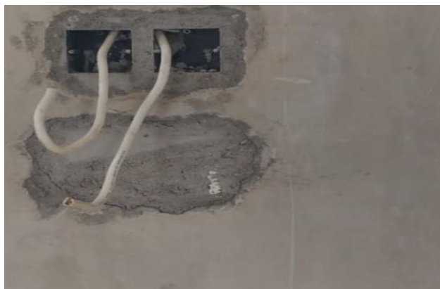
Gambar 4.13 Perubahan lokasi stopkontak
