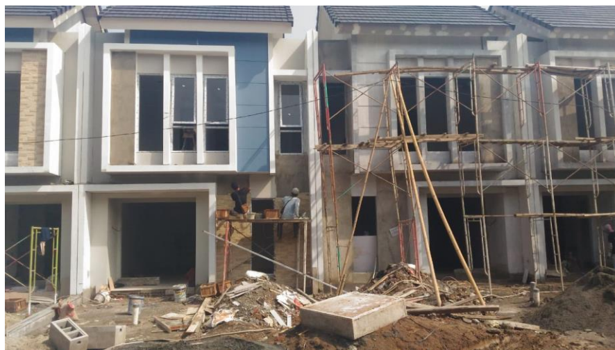
Gambar 4.18 Pemasangan batu alam
