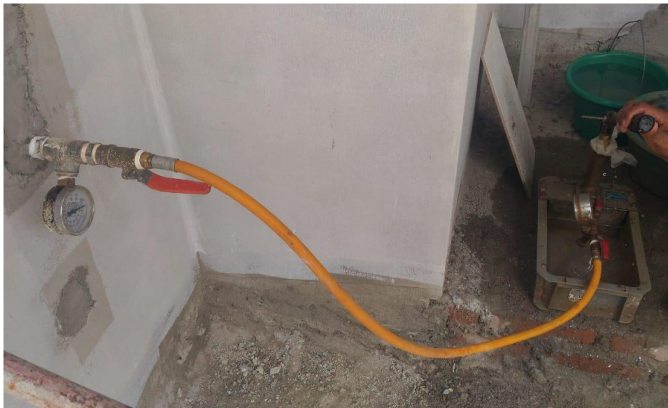
4.14 Pengujian tekanan pada instalasi pipa
