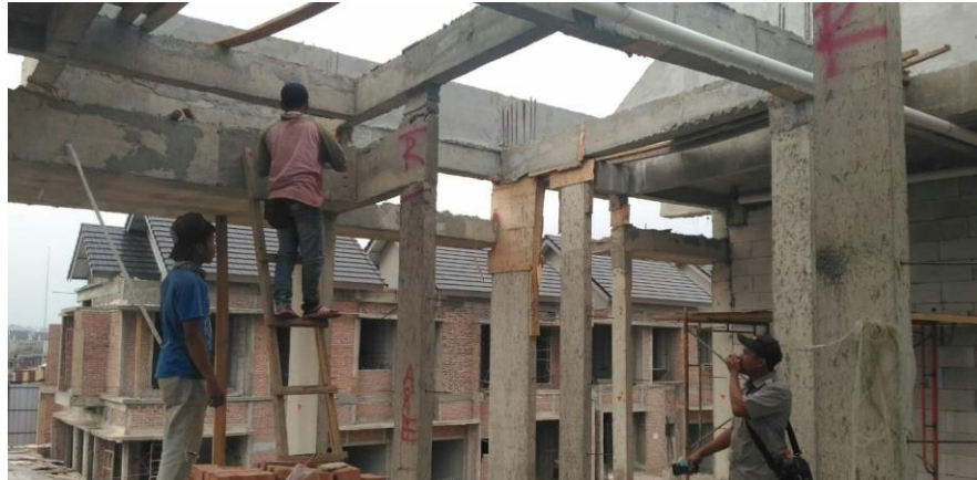
Gambar 4.3 Perbaikan pada beton yang keropos
