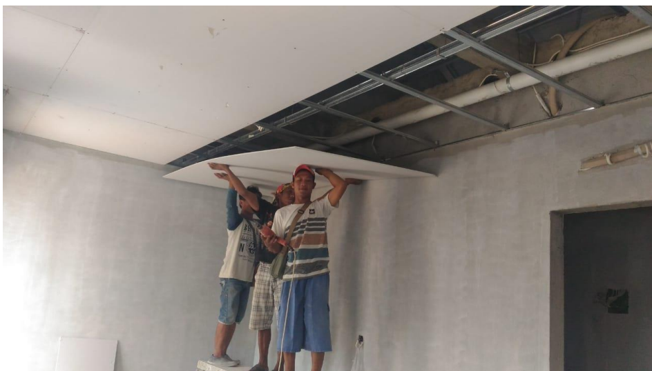
Gambar 4.8 Pemasangan plafond
