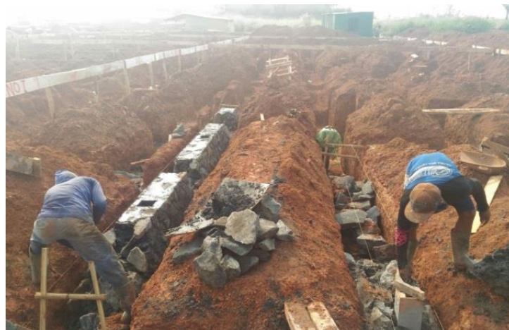
Gambar 4.2 Pemasangan pondasi batu kali
