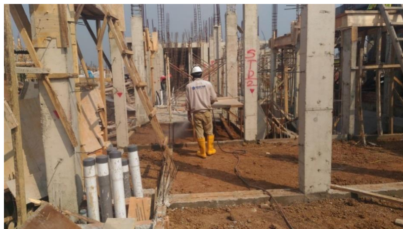
Gambar 4.17 Penyemprotan cairan anti rayap
