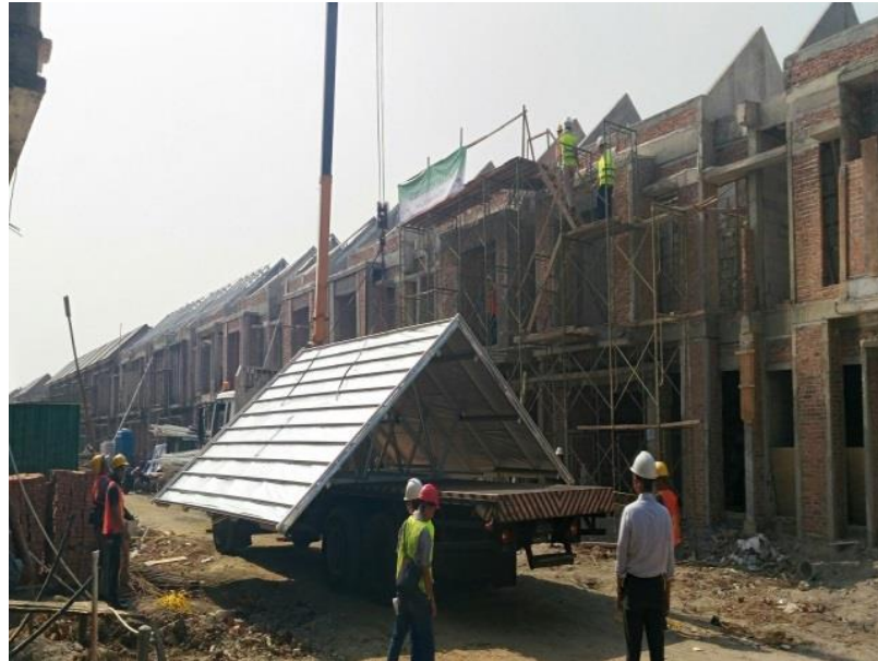
Gambar 4.7 Pemasangan penutup atap
