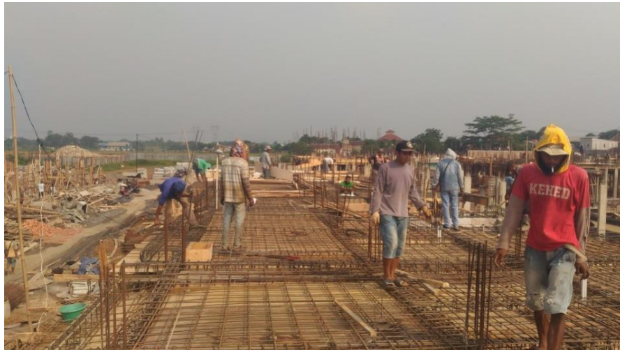
Gambar 4.5 Pemasangan bekisting pada plat lantai
