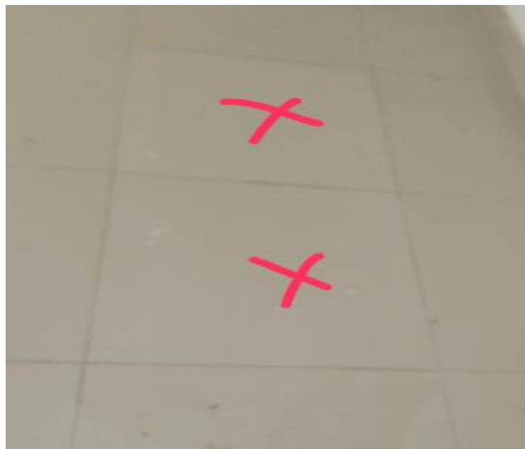
Gambar 4.10 Keramik yang tidak sesuai dengan pemesanan
