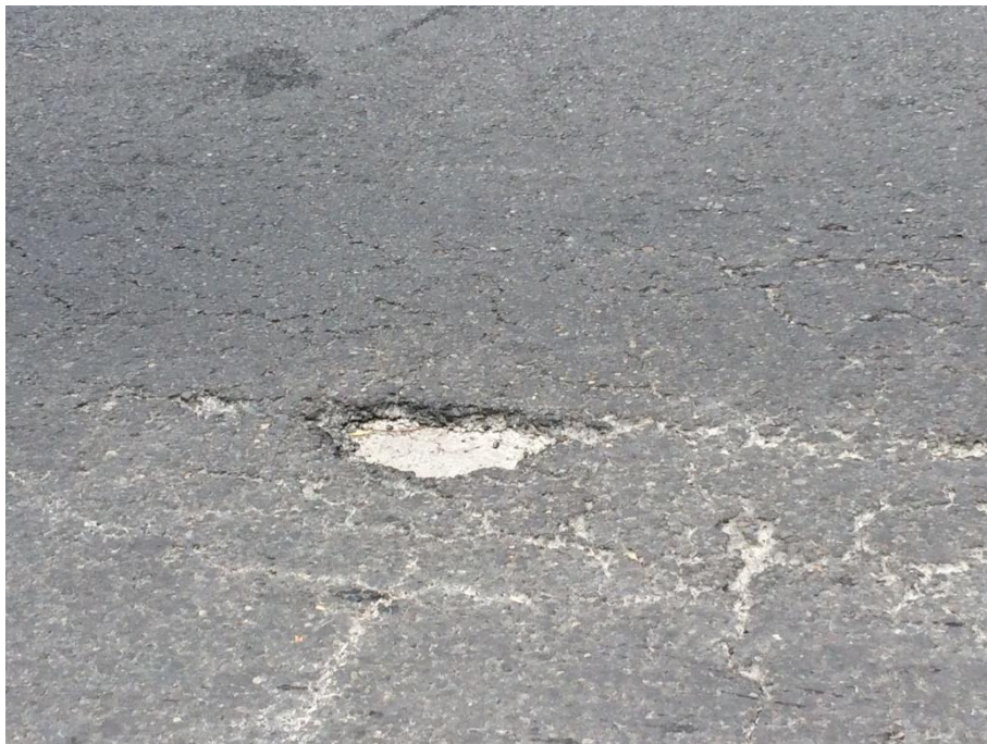
Gambar 8. Kerusakan Lubang
