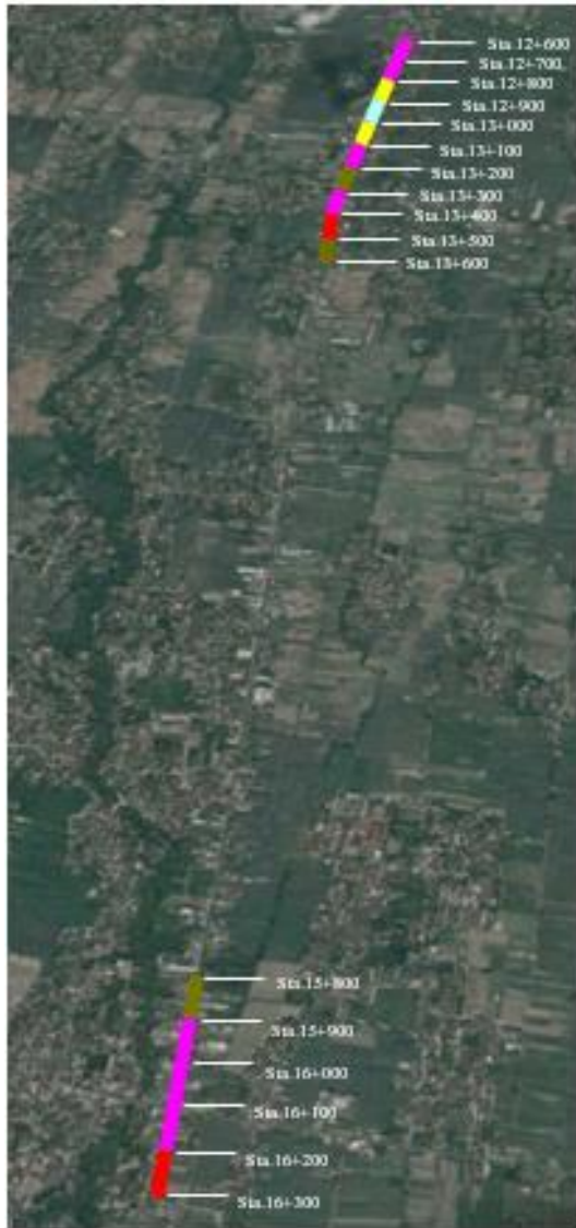
Gambar 15 Kondisi kerusakan jalan (Google Earth, 2019).
