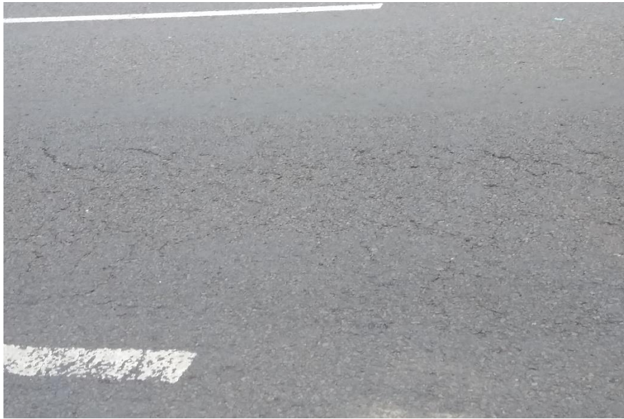
Gambar 5. Kerusakan Pelepasan Butir
