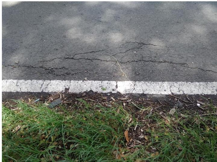
Gambar 2. 37 Retak Pinggir (*Edge Cracking*)
