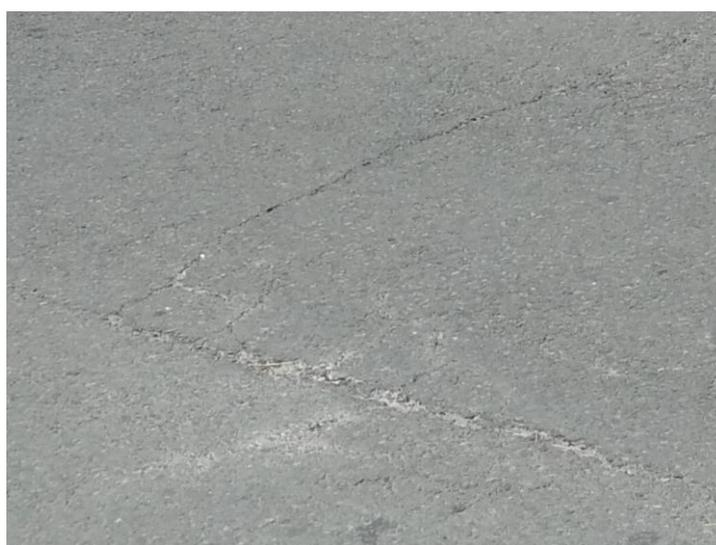
Gambar 2. 19 Retak Sambung (*Joint Reflect Cracking*)
