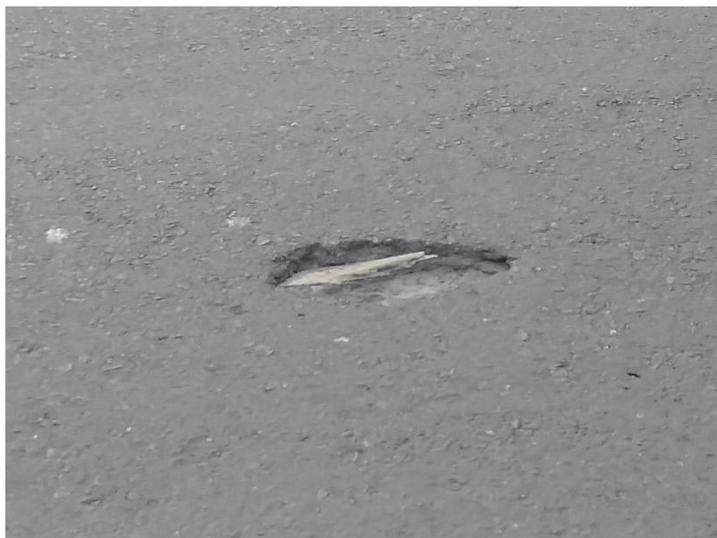
Gambar 2. 31 Kerusakan Lubang (*Pothole*)
