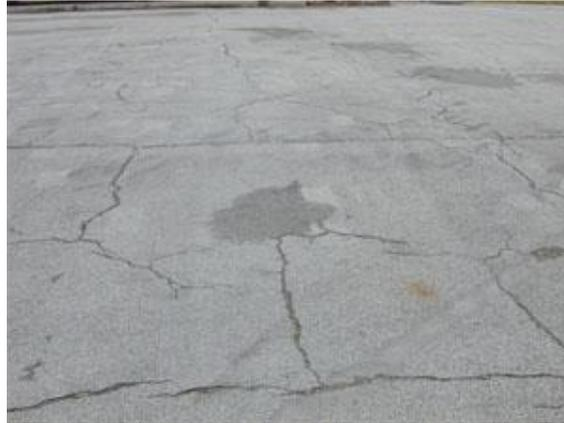
Gambar 2. 17 Retak Kotak-kotak (*Block Cracking*)
