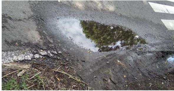
Gambar 2. 39 Pinggir Jalan Turun Vertikan (*Lane/Shoulder Dropp Off*)
