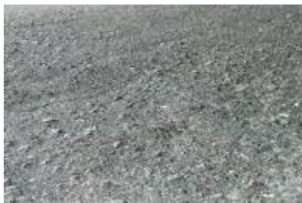
Gambar 2. 29 Kerusakan Pelepasan Butir (*Weathering/Ravelling*)
