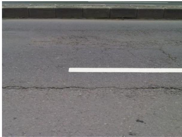
Gambar 2. 21 Retak Memanjang/Melintang (*Longitudinal/Transverse Cracking*)
