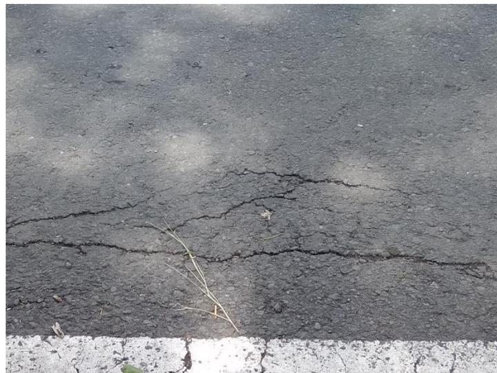
Gambar 2. 23 Kerusakan Retak Patah Slip (*Slippage Cracking*)
