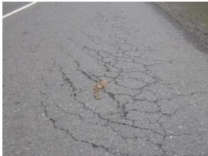
Gambar 2. 15 Retak Kulit Buaya (*Alligator Cracking*)
