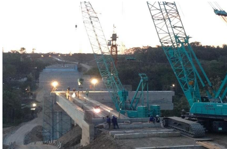
Gambar 2.4 Erection girder di jembatan kali kenteng dan serang
