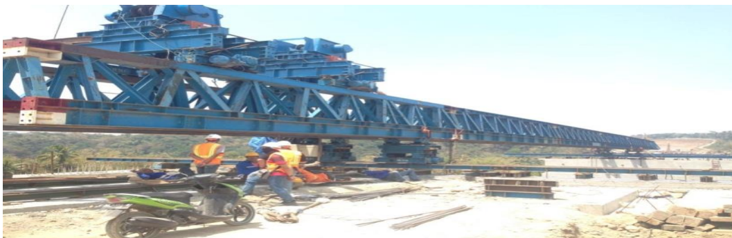
Gambar 2.2 Erection girder di jembatan kali kenteng dan serang
