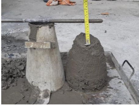
Gambar 121. Tinggi slump 9,5 cm
