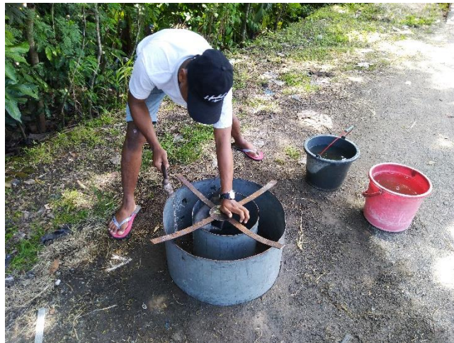
Gambar 2 Proses pemasangan alat
