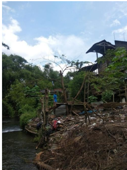
Gambar 4.12 Tumpukan sampah pada Jembatan Plemburan Sungai Code
