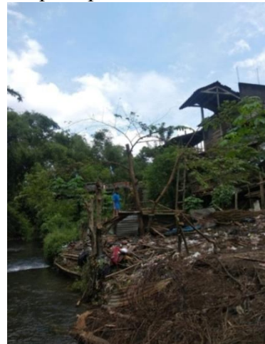
Gambar 4. Tumpukan sampah pada Jembatan Plemburan Sungai Code.
