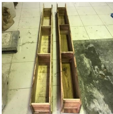
Gambar 3. 4 Bekisting balok
