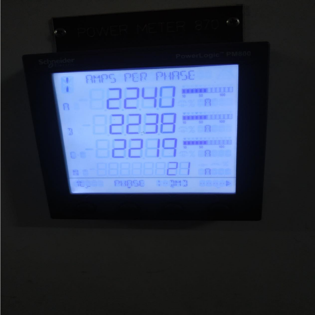
Lampiran 6. Gambar pengambilan data Arus Tiap Fasa ( Ampere )
