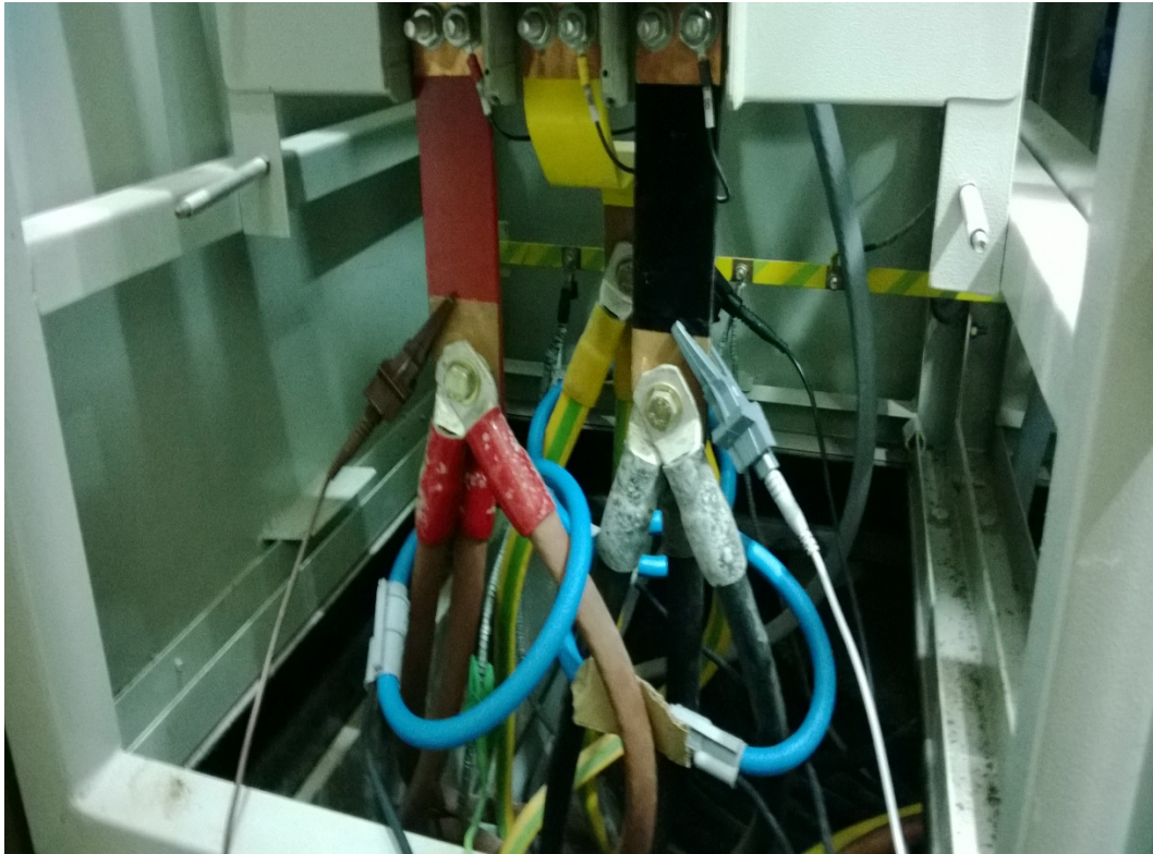
Gambar 7.5 Penghubungan Kabel Fasa RST dengan Kabel Metrel 2892
