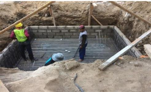
Gambar 4 Pekerjaan Penulangan Footplat
