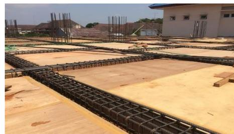
Gambar 17 Proses Pemasangan Bekisting Plat Lantai dan Plat Kanopi
