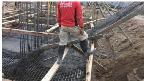
Gambar 5 Pekerjaan Pengcoran Footplat
