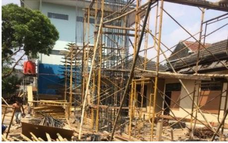
Gambar 9 Proses Penulangan Kolom Lantai Dasar
