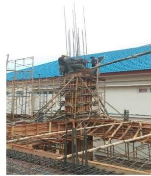
Gambar 15 Proses Pengecoran Kolom dan Balok Lantai
