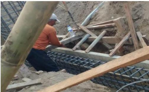
Gambar 7 Proses Pemasangan Bekisting Sloof
