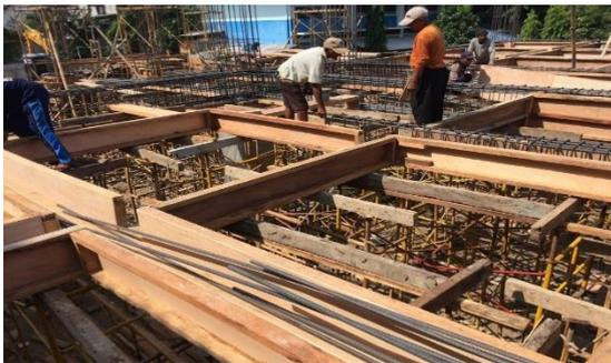
Gambar 14 Proses Pemasangan Bekisting Kolom dan Balok Lantai
