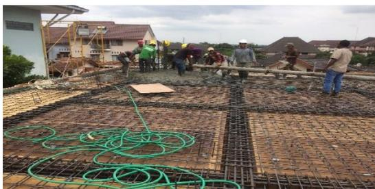
Gambar 19 Proses Pengecoran Plat Lantai dan Plat Kanopi
