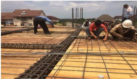
Gambar 18 Penulangan Plat Lantai dan Plat Kanopi
