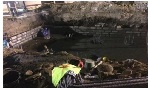
Gambar 2 Pembuatan Lantai Kerja Bawah Footplat
