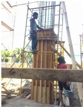
Gambar 10 Proses Pemasangan Bekisting Kolom Lantai Dasar
