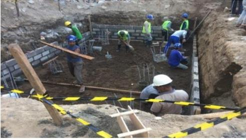
Gambar 3 Pekerjaan Pemasangan Bekisting Footplat
