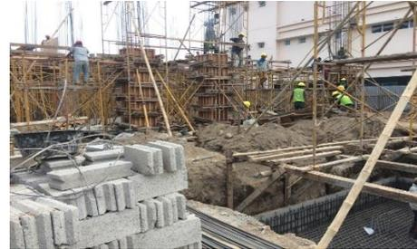
Gambar 11 Proses Pengecoran Kolom Lantai Dasar
