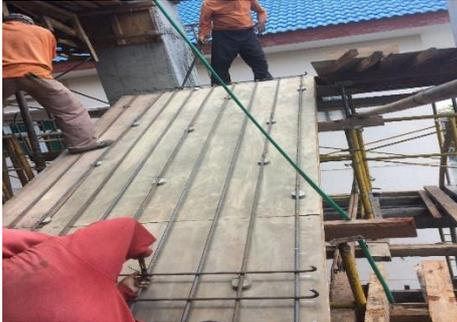
Gambar 16 Proses Pekerjaan Balok Tangga dan Plat Tangga
