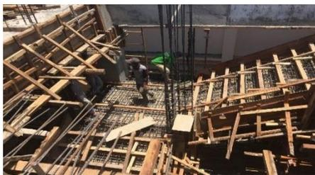
Gambar 12 Proses Penulangan Balok Sabuk, Balok Tangga dan Plat tangga
