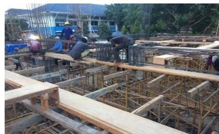
Gambar 13 Proses Penulangan Kolom dan Balok Lantai
