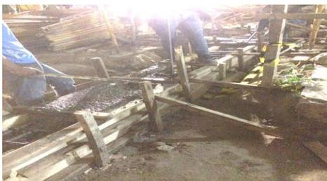
Gambar 8 Proses Pengecoran Sloof
