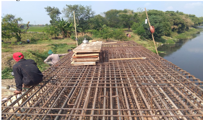
Gambar 4. 8 Pekerjaan Penulangan
