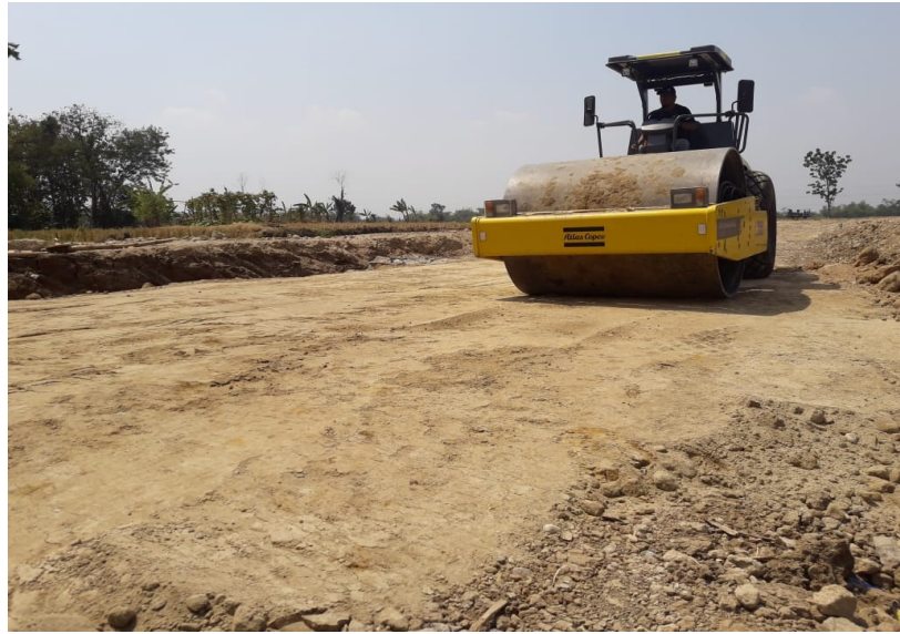
Gambar 4. 14 Pekerjaan Timbunan dan Pemasatan
