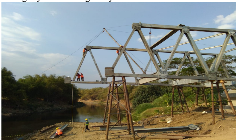
Gambar 4. 11 Pekerjaan Pemasangan Rangka Baja
