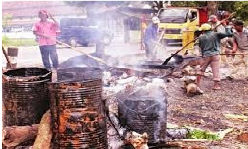
Gambar 4. 13 Pekerjaan Pembakaran Aspal
