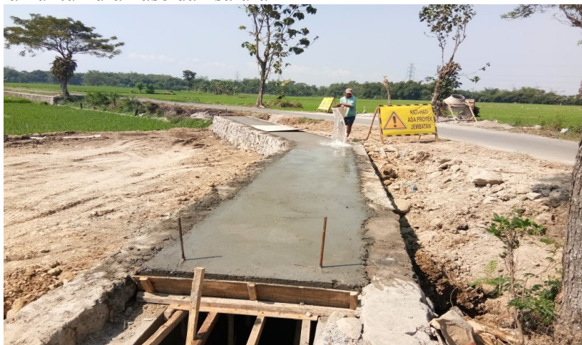
Gambar 4. 2 Pekerjaan Saluran Air
