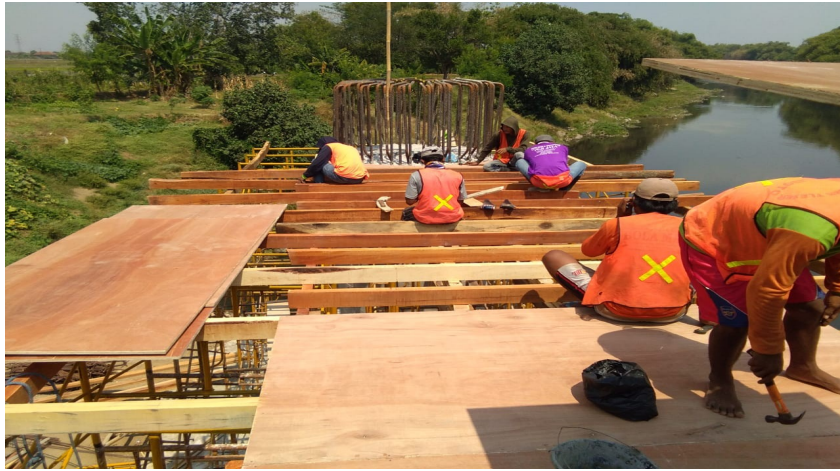
Gambar 4. 9 Pekerjaan Bekisting Kepala Pilar
