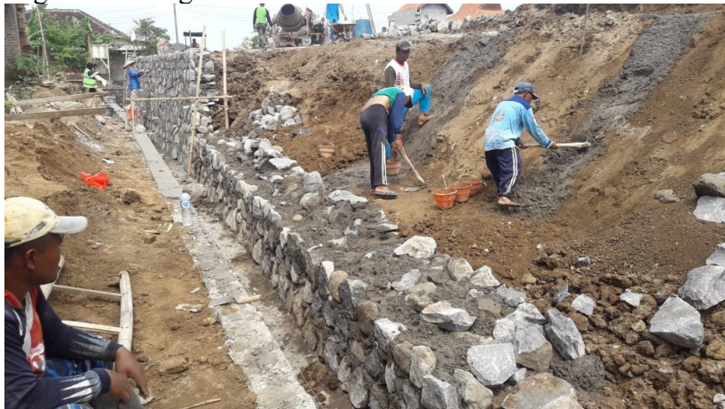
Gambar 4. 3 Pekerjaan Pasangan Batu
