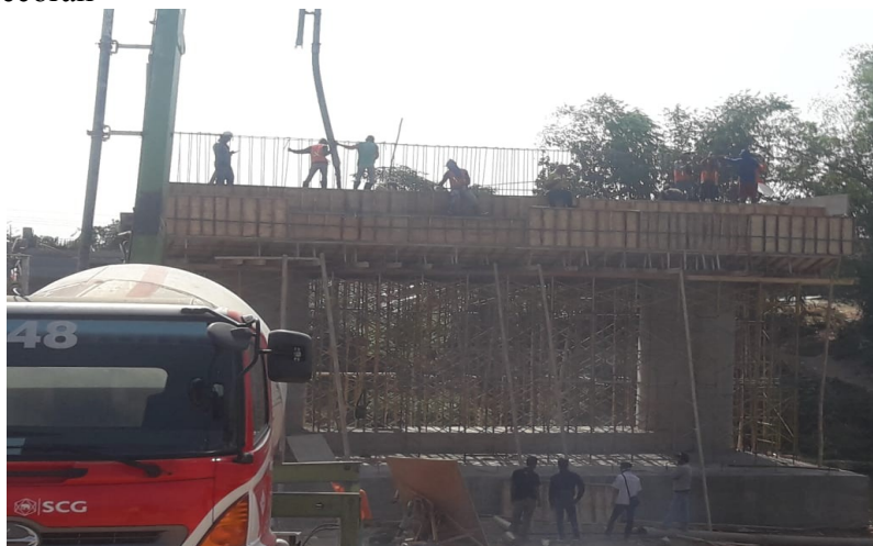
Gambar 4. 10 Pekerjaan Pengecoran Kepala Pilar
