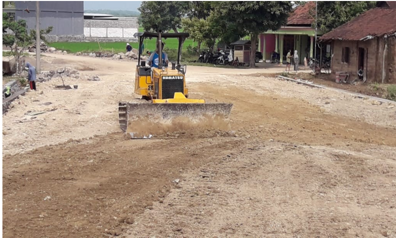
Gambar 4. 6 Persiapan Badan Jalan
