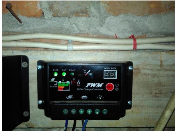
Gambar 4.3 Solar Charge Controller yang digunakan pada PLTS
