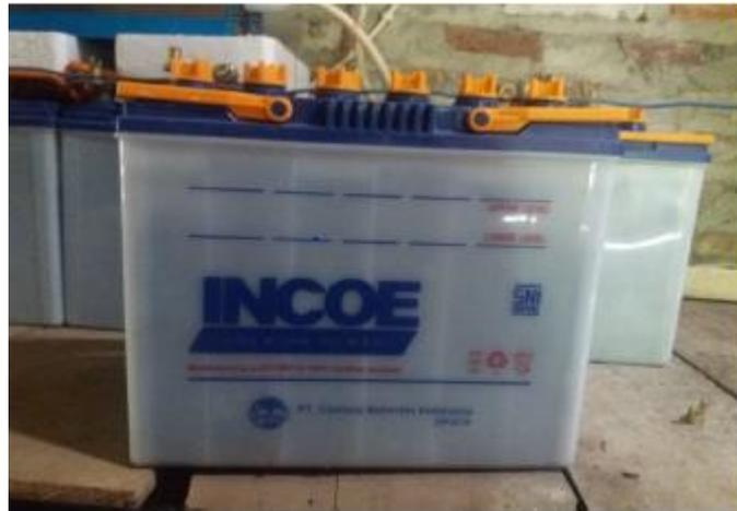
Gambar 4.2 Baterai yang digunakan pada PLTS
