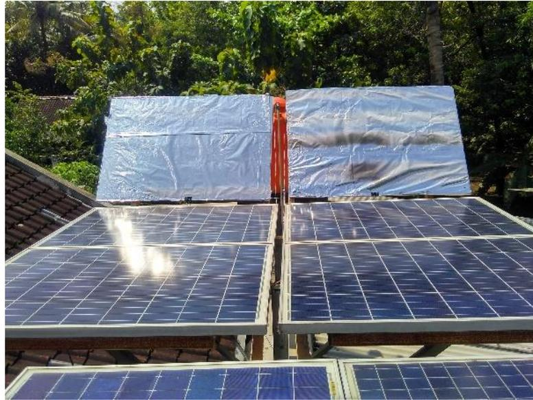
Gambar 4.5 Panel Surya dengan Reflektor Alumunium Foil
