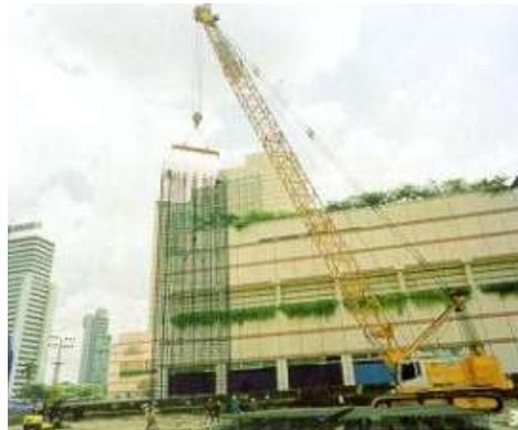
Gambar 4. 7 Pemasangan tulangan *diaphragm wall*
