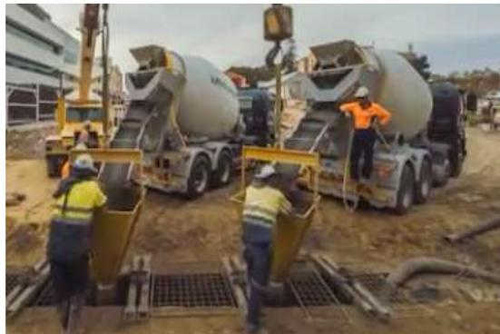
Gambar 4. 8 Pengecoran *diaphragm wall* di lapangan
