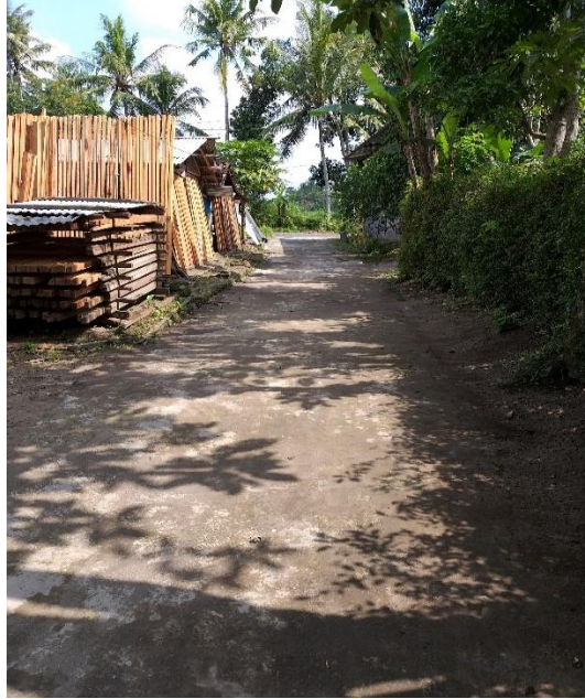
Gambar 3.5 Gambar Pengerasan Corblock di Dusun Kantongan
