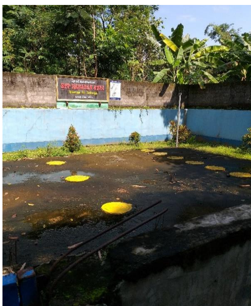
Gambar 3.21 Pembangunan SPAL di Dusun Sleman III
