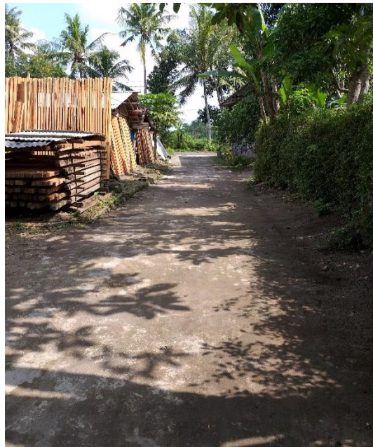
Gambar 3.11 Gambar Pengerasan Corblock di Dusun Kantongan
