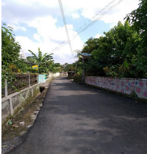
Gambar 3.9 Gambar pengaspalan jalan di Dusun Durenan Tejo
