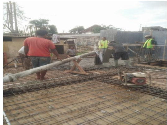
Gambar 10 Pekerjaan Struktur Lantai 2
