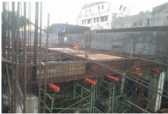
Gambar 8 Pekerjaan Struktur Lantai 1 Tabel 7 Nilai Risiko Pekerjaan Struktur Lantai 1
