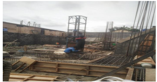
Gambar 6 Pekerjaan Basement Tabel 6 Nilai Risiko Pekerjaan Struktur Basement
