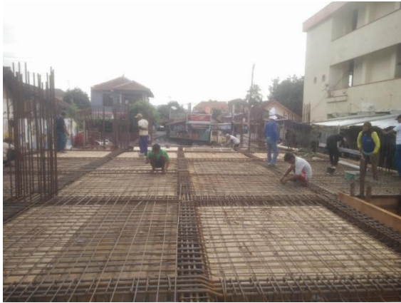
Gambar 12 Pekerjaan Struktur Lantai 3
