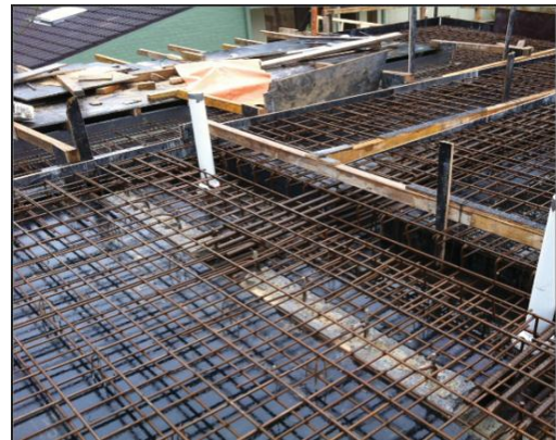
Gambar 14 Pekerjaan Struktur Atas
