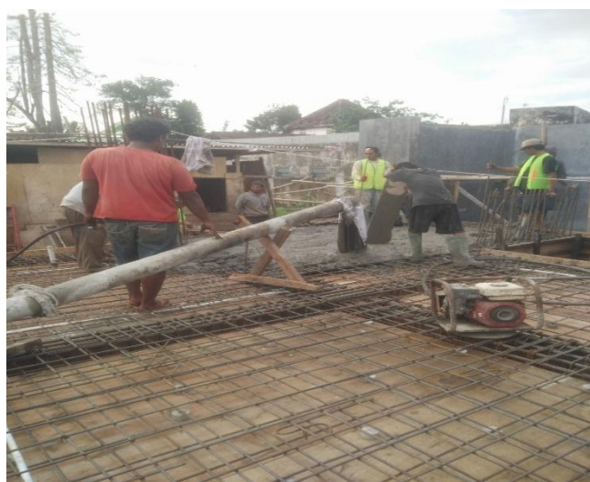
Gambar 4. 5 Proses Pekerjaan Plat Beton
