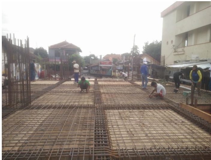
Gambar 4. 6 Pekerjaan Plat Beton
