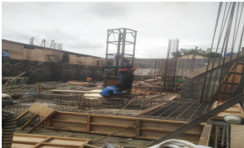
Gambar 4. 3 Proses Pekerjaan Lantai Basement
