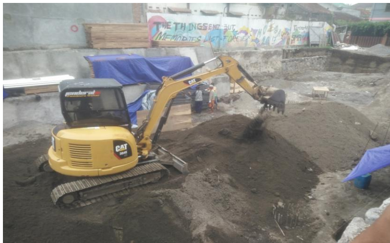
Gambar 4. 2 Proses Pekerjaan Urugan
