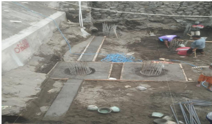
Gambar 4. 1 Proses Pekerjaan Pondasi
