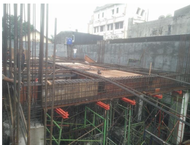
Gambar 4. 4 Proses Pekerjaan Struktur Lantai 1
