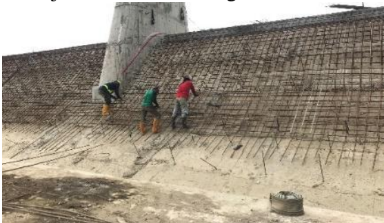
Gambar 5. Pekerjaan tubuh bendung
