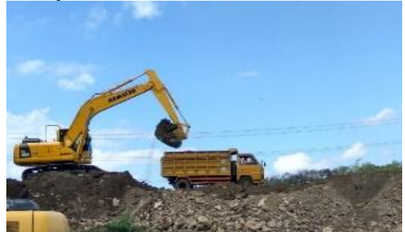
Gambar 3. Pekerjaan galian tanah
