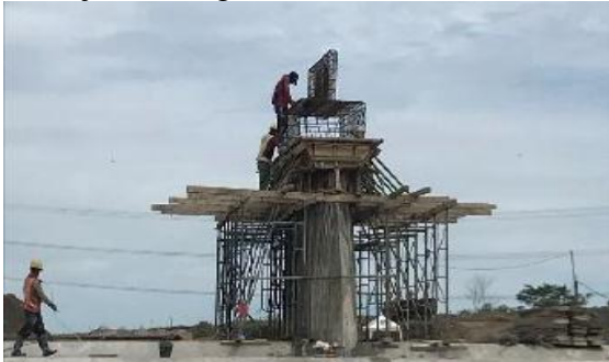
Gambar 7. Pekerjaan tiang mercu
