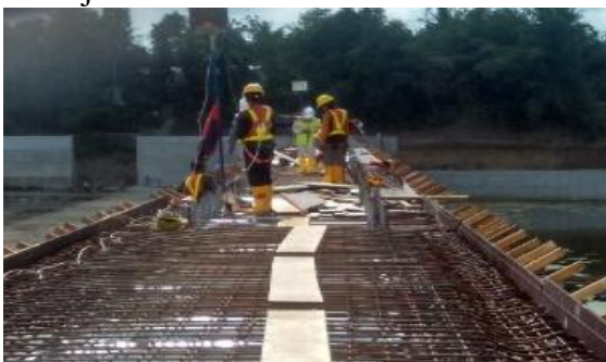
Gambar 11. Pekerjaan lantai jembatan
