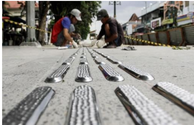
Gambar 1.2 : Pembangunan kawasan pedestrian
