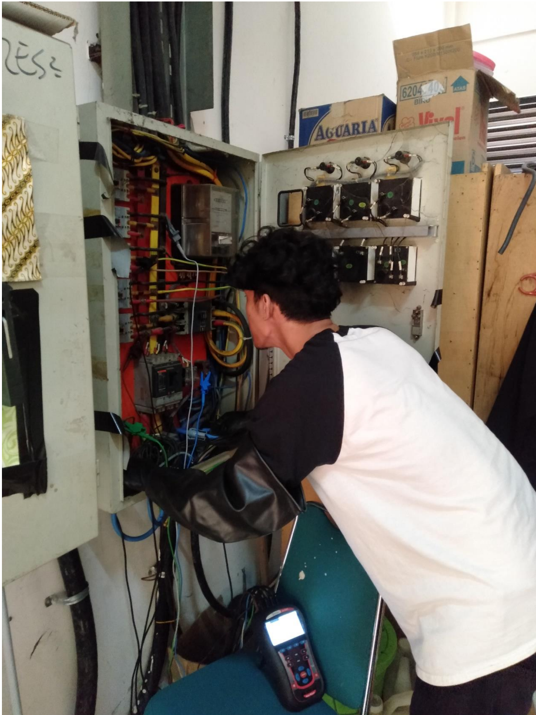
Gambar 3.11 Pemasangan metrel 2892-B ke panel SDP
