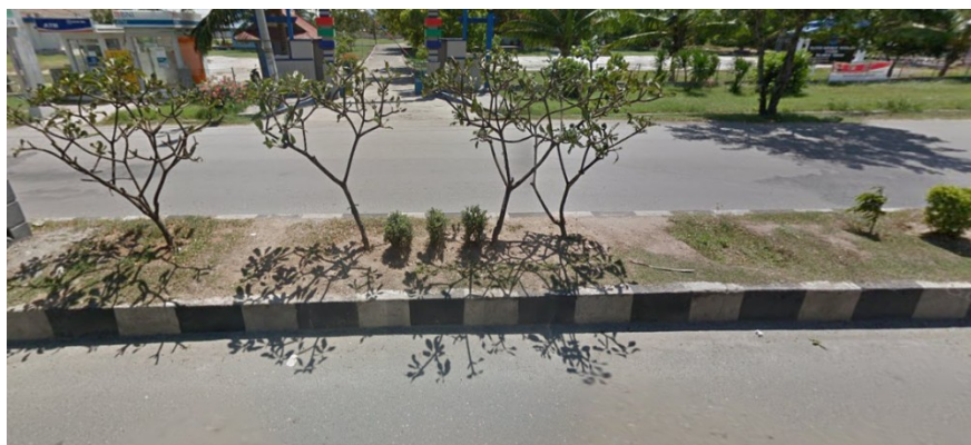
Gambar 14. Permasalahan di median jalan
