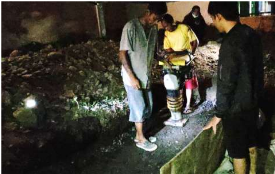
Gambar 3.17 Proses Pemadatan Tanah Menggunakan Stemper
