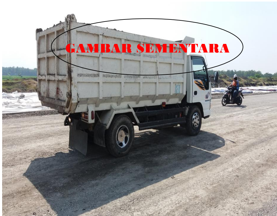
Gambar 3.3 Kondisi Ruas Jalan Argodadi ( Dokumentasi )
