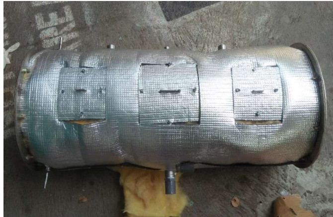
Gambar 3. 7. Tangki SWH sudah terpasang glasswool dan alumunium foil
