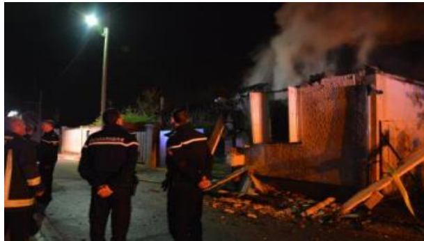
Gambar 3. 5 Pembakaran Ruang Doa Chateau-Thierry
