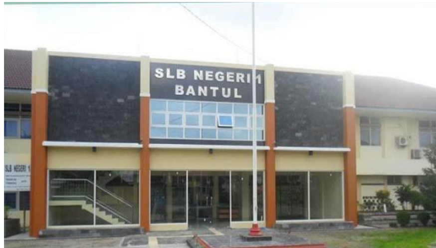
Gambar 1. Gedung Utama SLB N 1 Bantul
