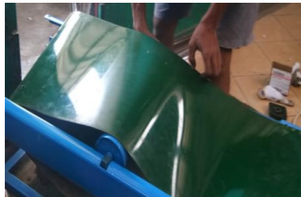
Gambar 4.17 Pemasangan roller dan belt conveyor
