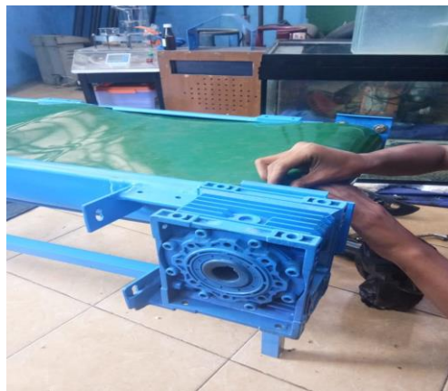
Gambar 4.23 Pemasangan motor dan gear box
