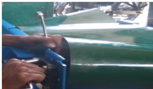
Gambar 4.18 Pemasangan bearing pada roller conveyor
