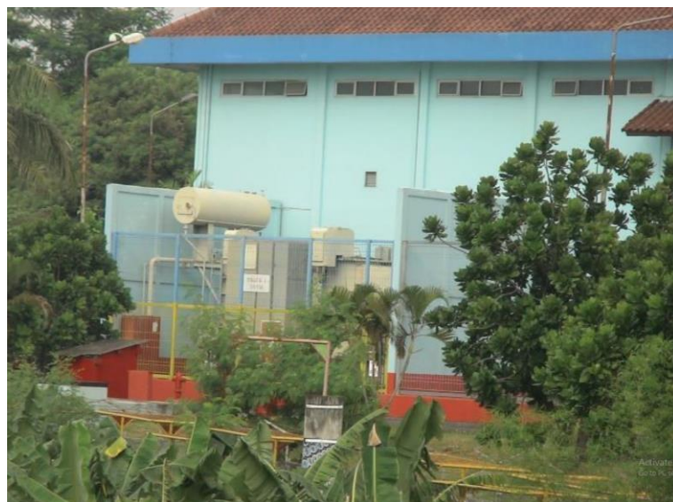
Gambar 2.14. Gardu Induk Pasang Setengah Luar
