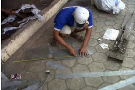
Gambar 3.4 pemotongan plat galvanis
