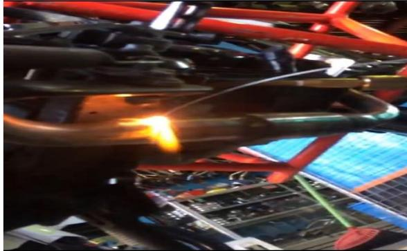
Gambar 3.15 penyambungan pipa header bagian belakang
