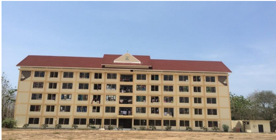
Gambar 4. 1 Gedung Rusunawa Tuksono
