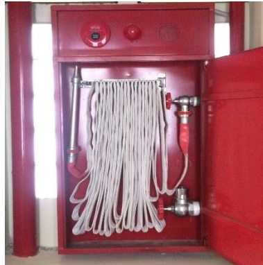
Gambar 4. 13 Hidran Gedung
