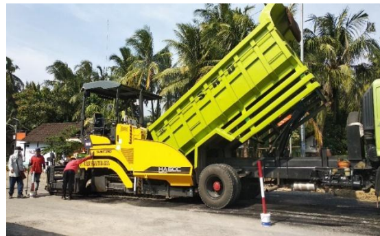
Gambar 4 Pekerjaan Perkerasan Aspal
