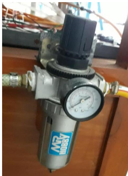
Gambar 3.12. Regulator dan Filter
