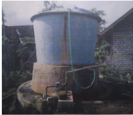
1. Tanki penampung air untuk penyiraman.
