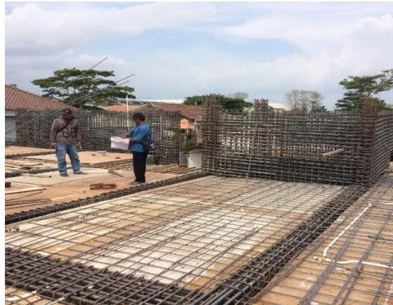
Gambar 4.4. perakitan pelat lantai 2
