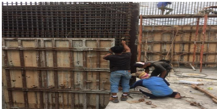
Gambar 4.10. Pekerjaan Bekisting Shearwall
