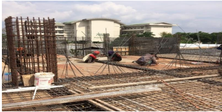
Gambar 4.8. Pekerjaan Struktur Lantai 6
