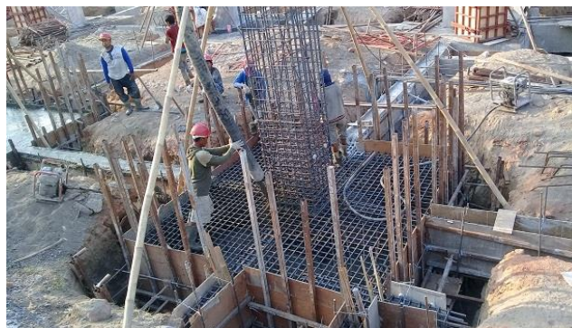
Gambar 4.1 proses pengecoran slof dan pile cap
