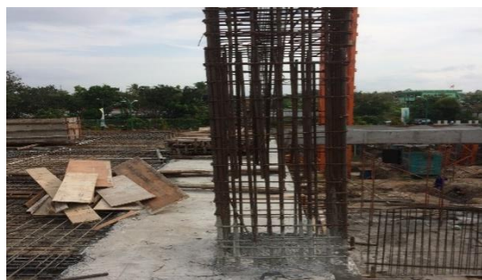
Gambar 4.5. pekerjaan kolom lantai 3
