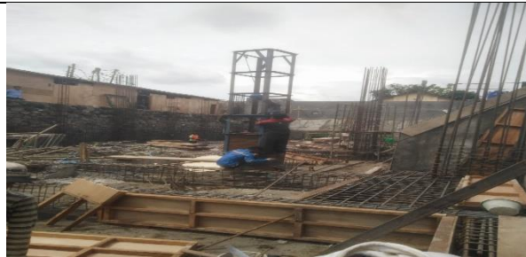
Gambar 4.2. proses pengerjaan pelat lantai basement dan kolom
