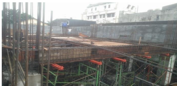
Gambar 4.3. pekerjaan struktur lantai 1
