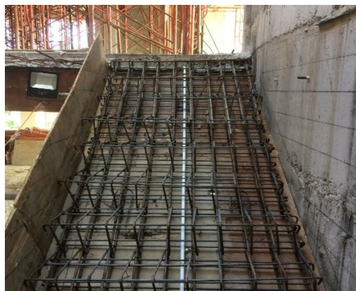
Gambar 4.6. pekerjaan tangga pada struktur lantai 4
