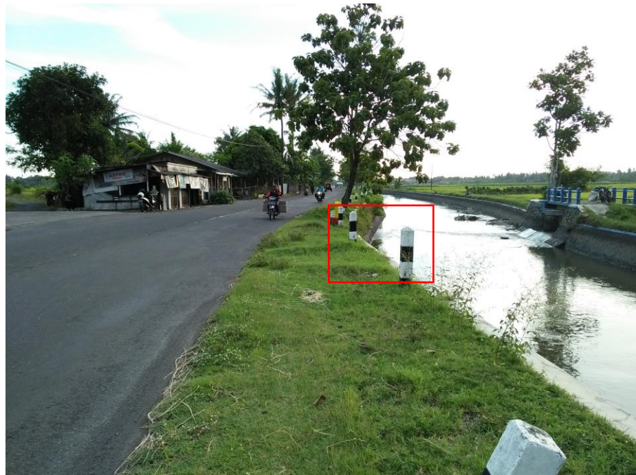
Gambar 4.14 Kondisi pagar pengaman jalan
