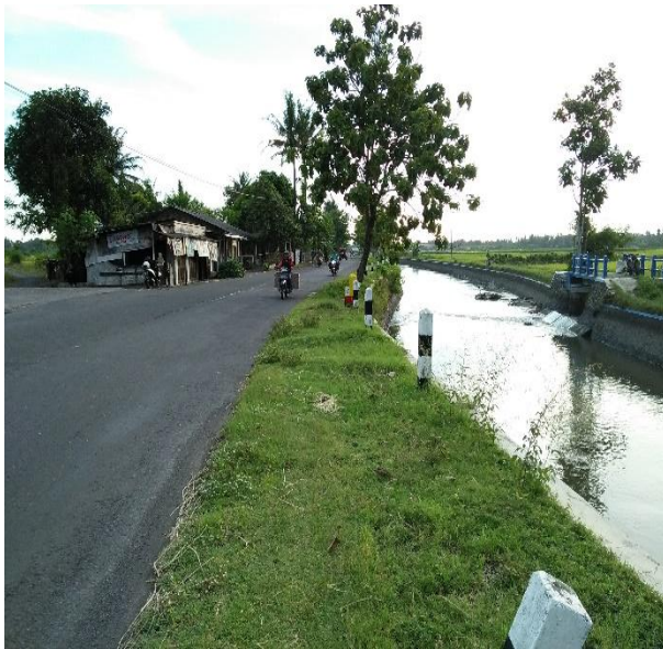
Gambar 5 Kondisi pagar pengaman jalan
