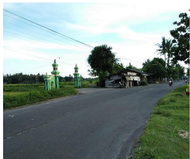
Gambar 3 Kondisi ruas jalan dimana tidak terdapat lampu penerangan jalan
