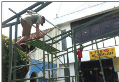
(a) Pemasangan rangka atap
