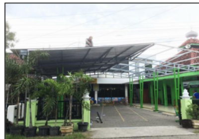
(b) Pemasangan penutup atap
