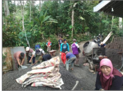
(d) Pengecoran lantai atas.
