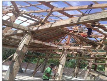
(f) Pemasangan atap lantai 2.
