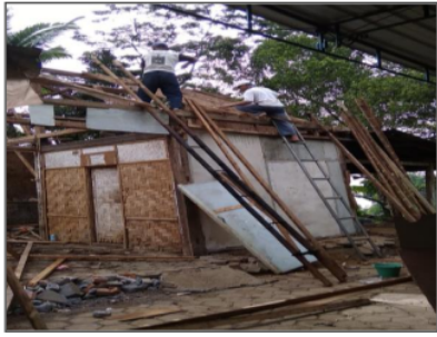
(a) Pembongkaran bangunan lama.
