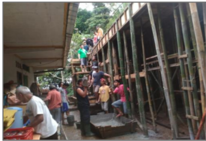
(e) pengecoran lantai atas.
