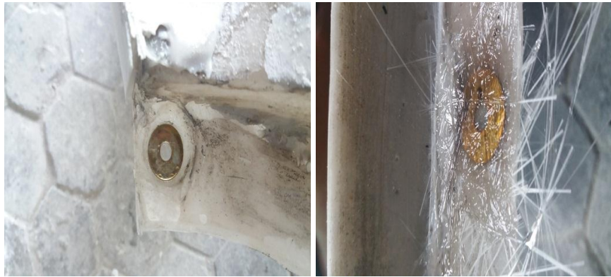
Gambar 4.3 Lubang Baut DiBeri Ring
