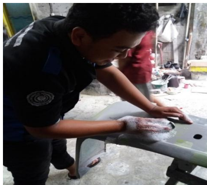
Gambar 4.14 Pengamplasan menggunakan air dan sabun
