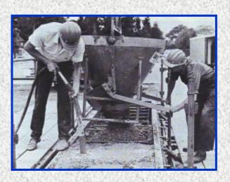
Cetakan harus kokoh, bersih dan rapat/tidak bocor. Permukaan cetakan yang bersinggungan langsung dengan beton dapat dilapisi minyak agar beton tidak melekat pada cetakan, sehingga memudahkan pembongkaran cetakan
